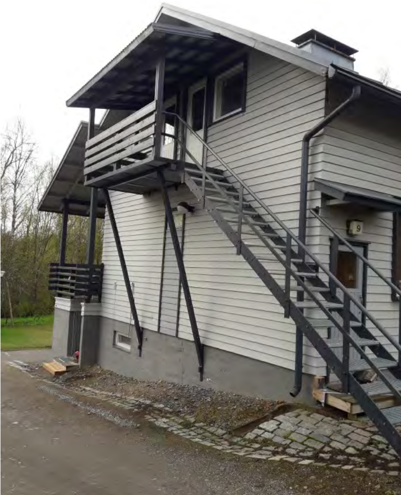
Molempiin pätyihin on rakennettu sisäänkäynnit.
