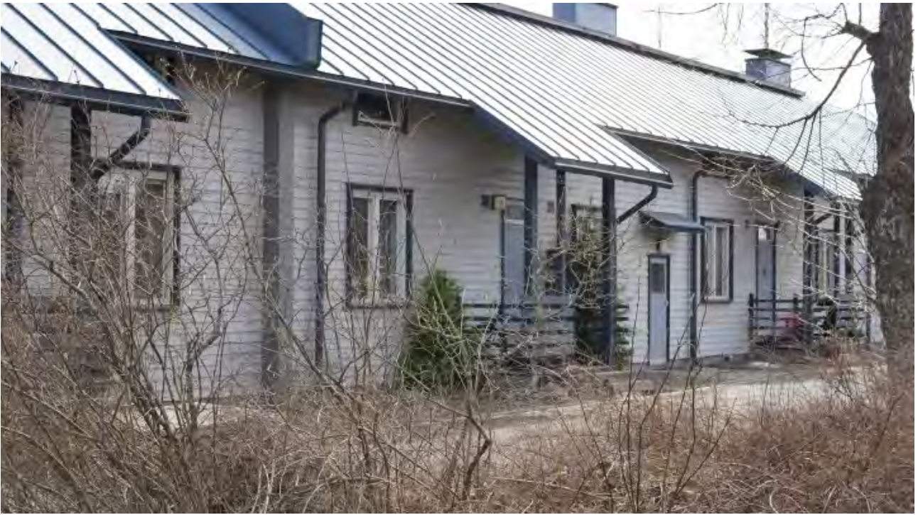
Rakennuksen julkisivua Pajakadun suunnasta.
