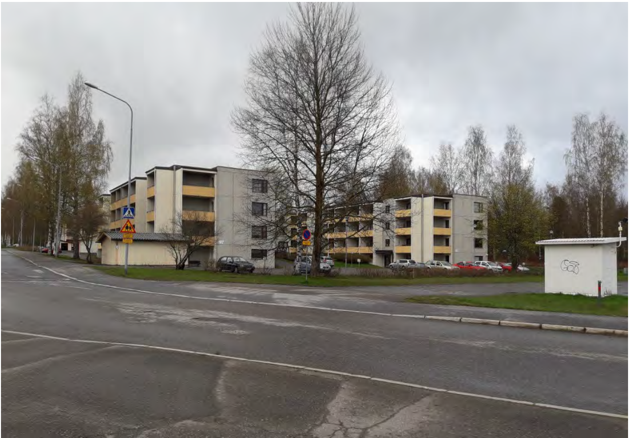
Kylmäseman takana olevaa kerrostalomassaa, kuvattuna Peitsarinkujalta.
