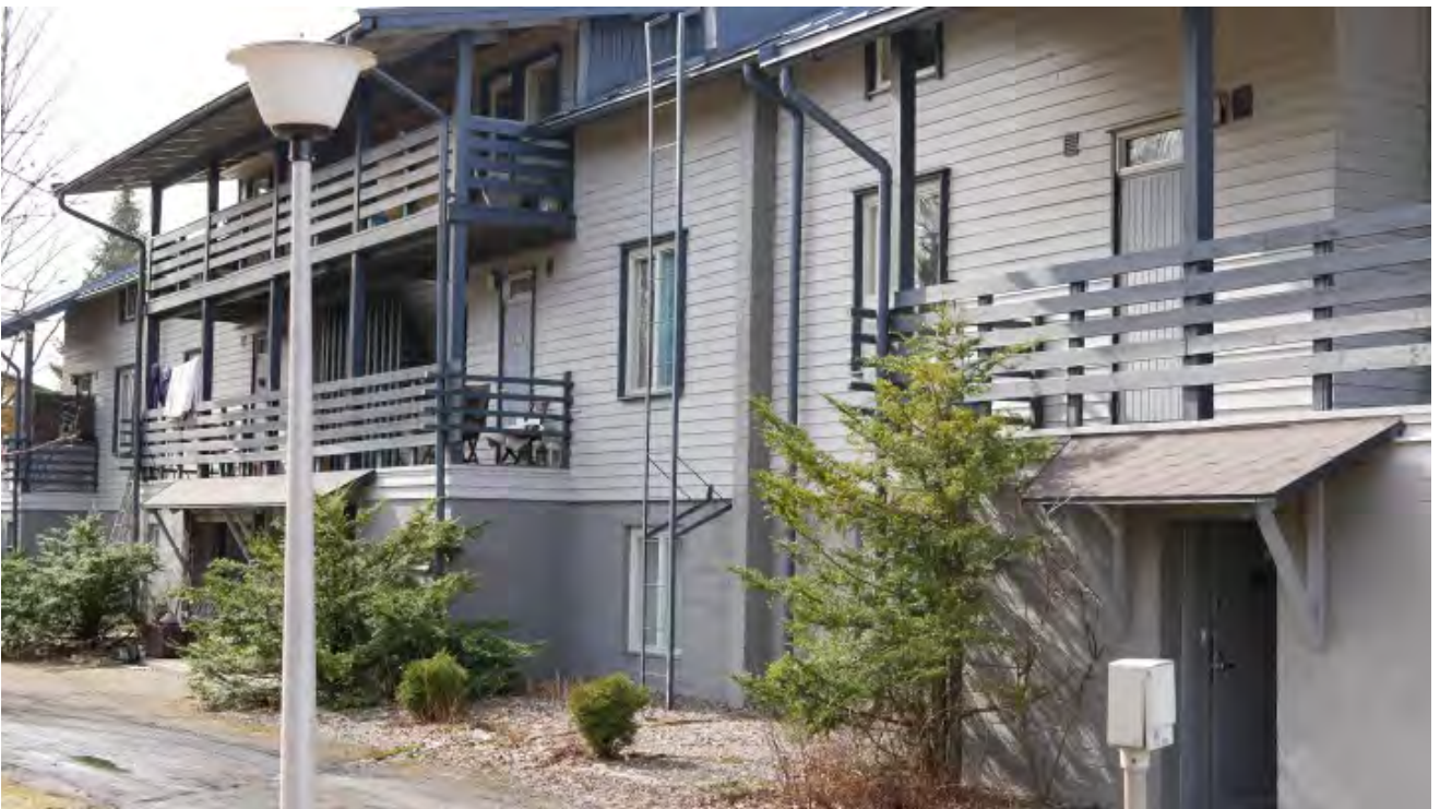
Pajakadun julkisivua pihan puolelta.
